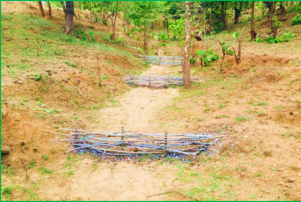
ညောင်ဦးခရိုင်၊ ကျောက်ပန်းတောင်းမြို့နယ် သစ်ကိုင်းဖျားသုံးနန်းထိန်းတမံငယ်ပြုလုပ်ခြင်း
