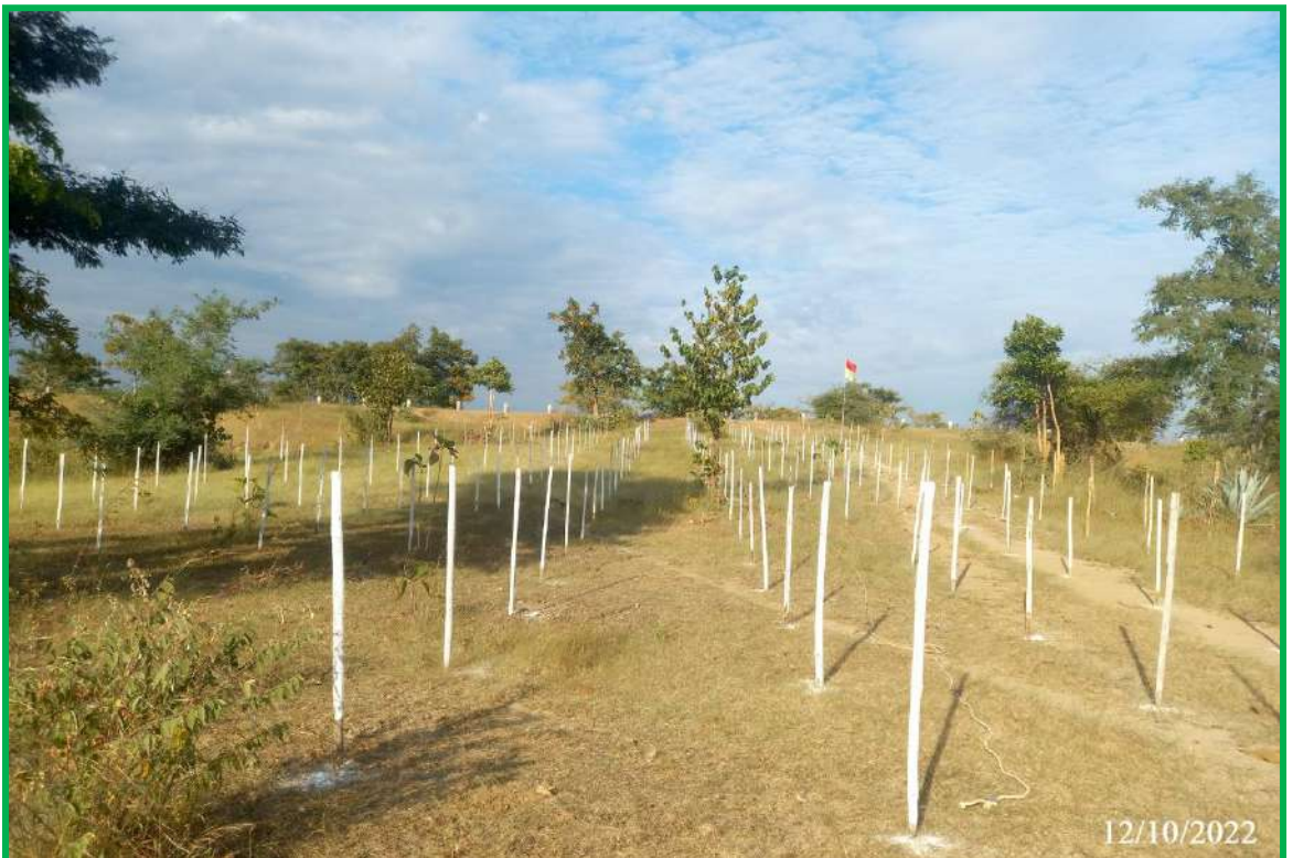
ရေနံချောင်းမြို့နယ်အထူးစိမ်းလန်းစိုပြည်ရေးဇုန်စီမံကိန်း (Greening Complex Zone) ၆/၂၀၂၃ တောထိန်းကွက်လပ်ဖြည့်(၃၅၀၀)ပင် စိုက်ခင်း ပန္နက်ရိုက်ခြင်းလုပ်ငန်း
