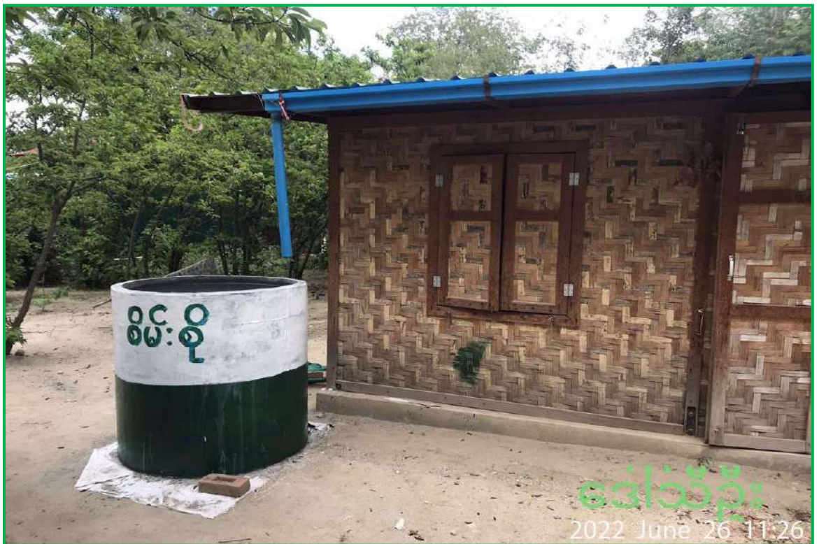
စစ်ကိုင်းခရိုင်၊ စစ်ကိုင်းမြို့နယ်၊ ရွှေမင်းဝံလုပ်ကွက်၊ ဂါလန် (၂၀၀) ဆုံ မိုးရေခံကွန်ကရစ်ကန် ပြုလုပ်ခြင်း
