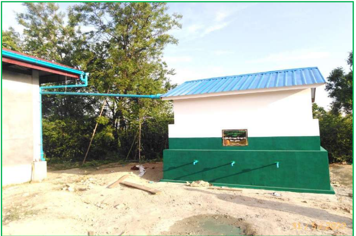
ပခုက္ကူခရိုင်၊ ရေစကြိုမြို့နယ်၊ မြေနီကုန်းကျေးရွာ၊ ဂါလန်(၅၀၀၀)ဆံ့ မိုးရေစုကန်တည်ဆောက်ခြင်း
