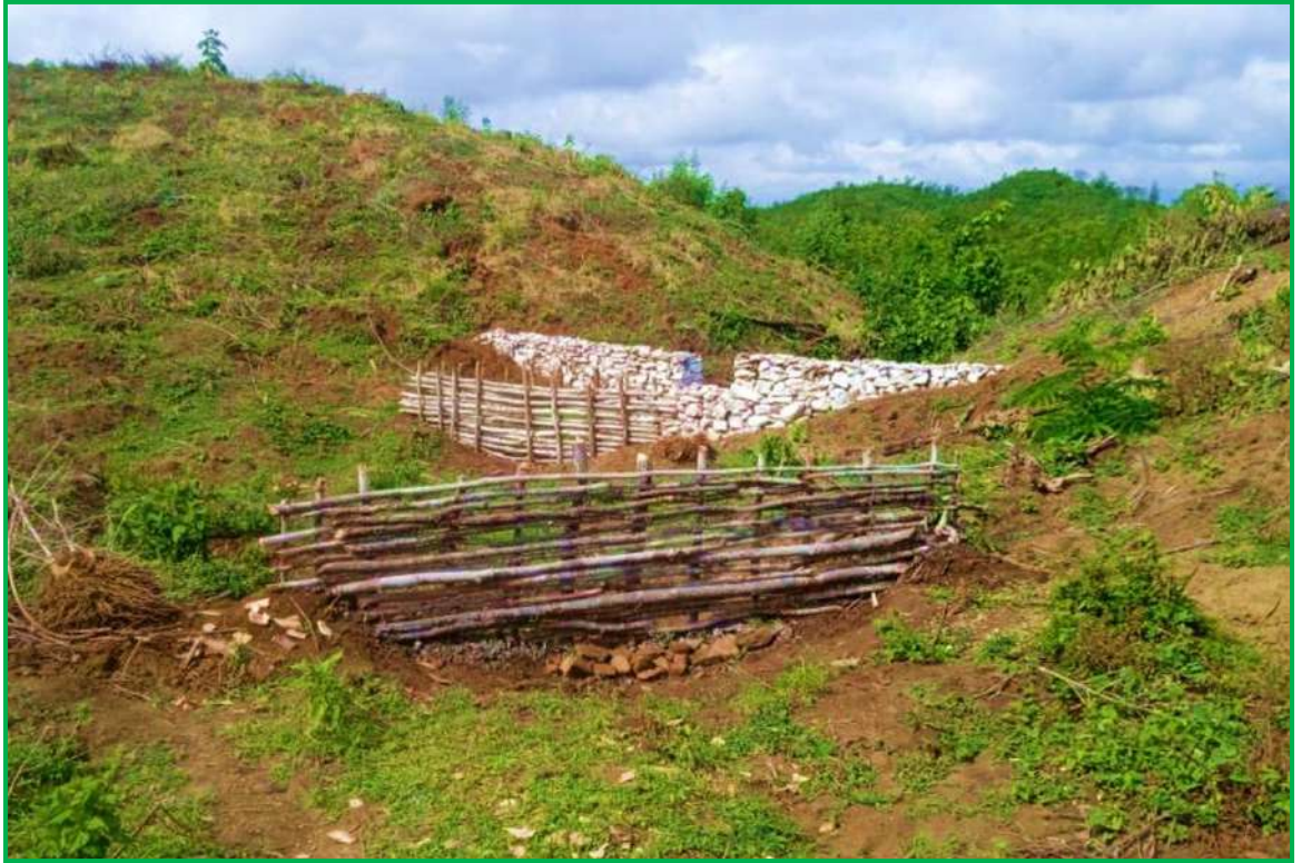
မင်းဘူးခရိုင်၊ ငမဲမြို့နယ် သစ်ကိုင်းဖျားသုံးနန်းထိန်းတမံငယ်ပြုလုပ်ခြင်း
