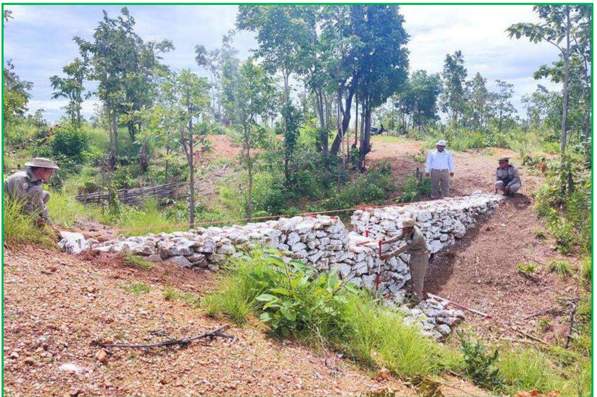
မင်းဘူးခရိုင်၊ မင်းဘူးမြို့နယ်၊ ကျောက်စီနုန်းထိန်းတမံငယ်အမှတ်(၃)ပြုလုပ်ခြင်း
