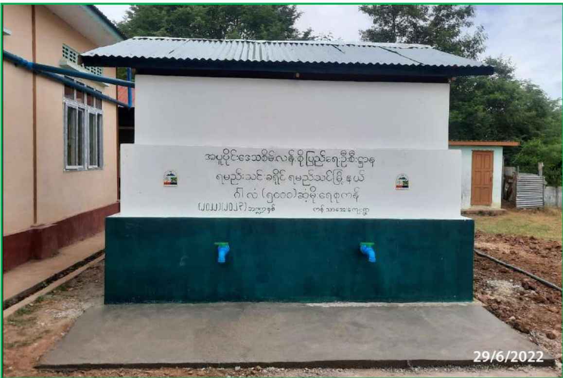
ရမည်းသင်းခရိုင်၊ ရမည်းသင်းမြို့နယ်၊ ကန်သာအေးကျေးရွာ ဂါလန်(၅၀၀၀) ဆံ့ မိုးရေစုကန် တည်ဆောက်ခြင်း
