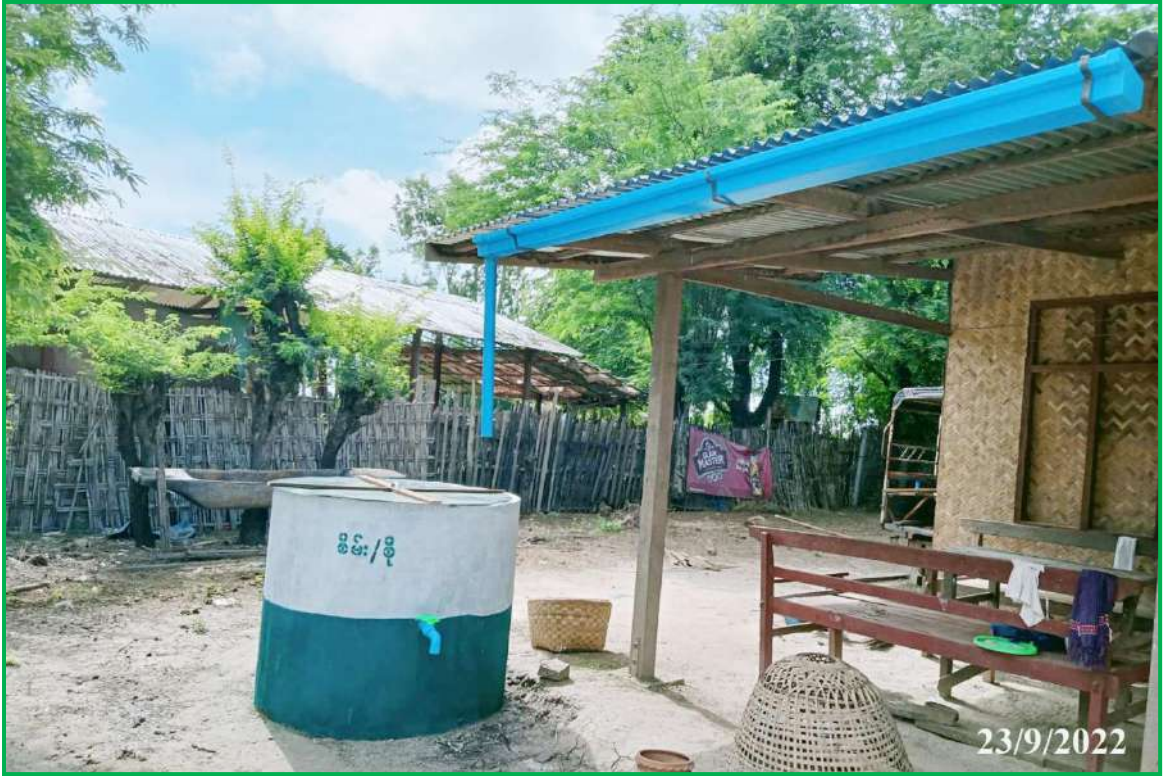
ရွှေဘိုခရိုင်၊ ရွှေဘိုမြို့နယ်၊ ထနောင်းဝန်းကျေးရွာ၊ ဂါလန်(၂၀၀) ဆုံ မိုးရေခံကွန်ကရစ်ကန် ပြုလုပ်ခြင်း
