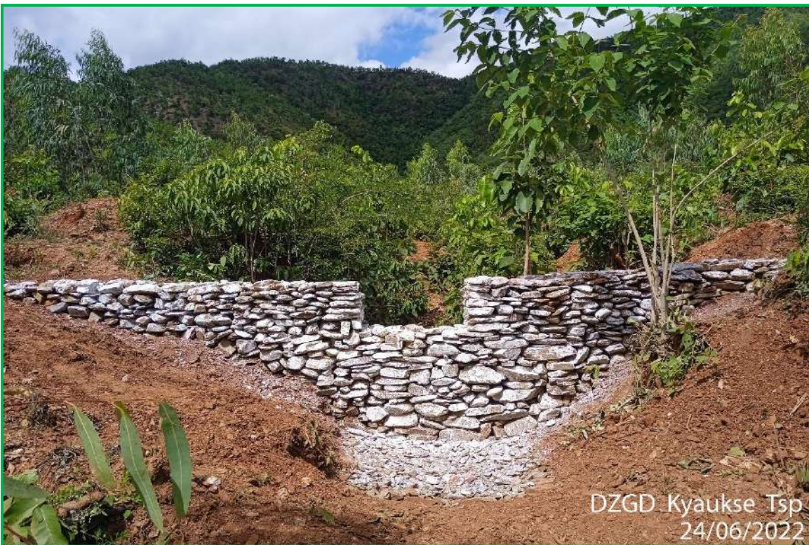
ကျောက်ဆည်ခရိုင်၊ ကျောက်ဆည်မြို့နယ်၊ ကျောက်စီနုန်းထိန်းတမံငယ်အမှတ် (၃) ပြုလုပ်ခြင်း
