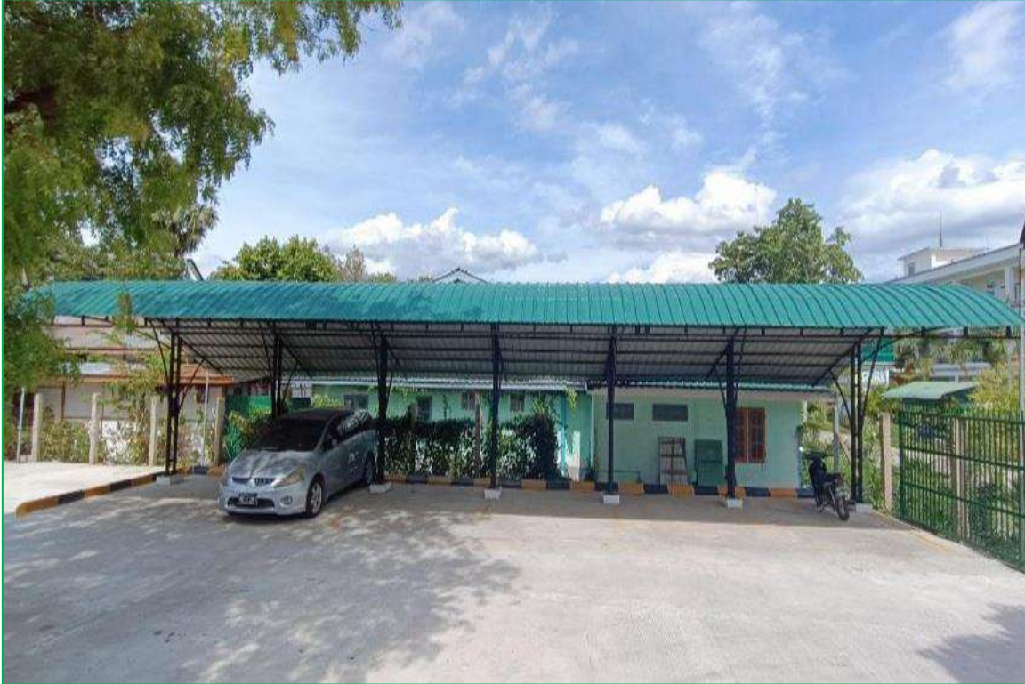
ယာဉ်ရပ်နားဆောင်(၂)ခုအကြား ယာဉ်အဝင်အထွက် ကွန်ကရစ်လမ်းခင်းခြင်း (၆၀'x၂၅'x၆')(၁၅၀၀၈တုရန်းပေ)
