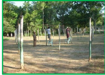
ဖျိုးစင်တည်ဆောက်ခြင်း
